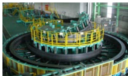
鋼鐵設備工程
