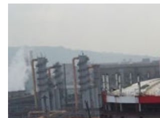
中鋼高爐氣儲槽更新統包工程
