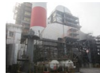
中鋼三號燒結廢棄脫硫系統工程
