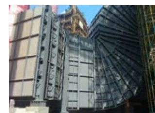
中鋼 W2#2SP FGD/SCR 製裝工程
