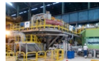
中鋼 W4 鋼板工場強力冷整平機統包工程
