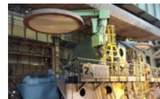
中龍扁鋼胚連鑄機轉台盛鋼桶加蓋設備增設工程
