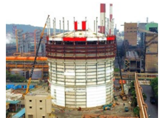
中鋼 W5 高爐氣儲槽
