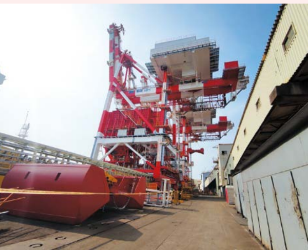
▲中機於中鋼#97碼頭完成兩部新卸船機安裝。
