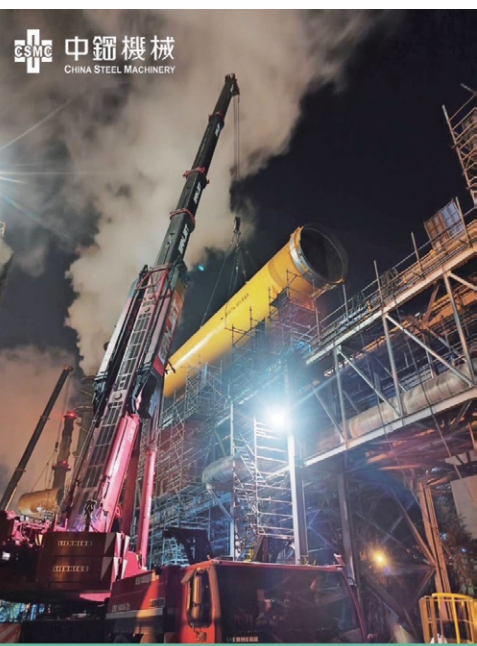
中機完成中鋼W5更新高爐氣管線及目鏡閥工程
